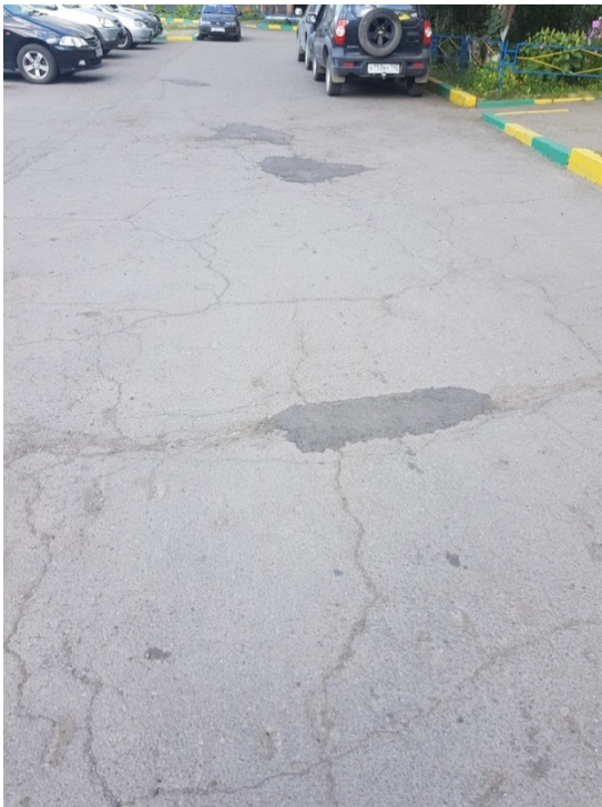
Рис.№ 2. Состояние покрытий проездов.
